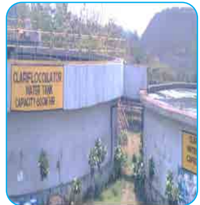
STP, ERS & WATER TREATMENT
